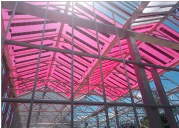
Fig.20 Módulos semitransparentes desarrollados por LUMO [140]
