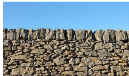
Muro de piedra en seco en Vilafranca (Castellón). FRANCESC MIRALLES
