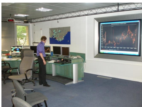
Compuerta motorizada y automatizada; sala de control.
