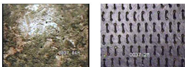
Ilustración 8.- Estado pre y post tratamiento de rejillas
